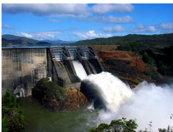
Centrale hydroélectrique de Nangbeto (Togo)
